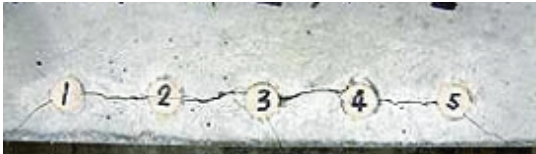
ひび割れを発生させた試験体
