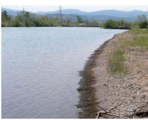
C Fネットで土砂の流失を保護。天然繊維のネットは植物の成長を阻害しません。 流れてくる植物の種子も捕捉しやすい構造になっています。
